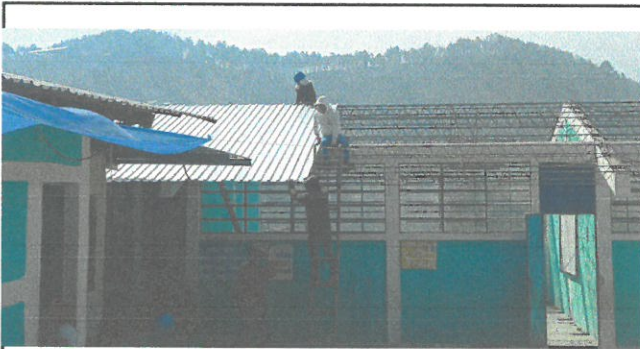
TECHO DE AULA
