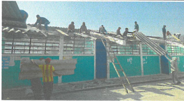
VISTA DE ÁREA DE REMOZAMIENTO DE TECHO
