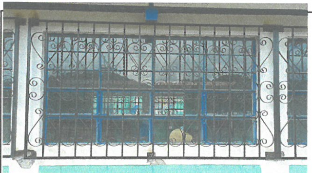
VISTA DE AREA DE REMOZAMIENTO DE BALCON
