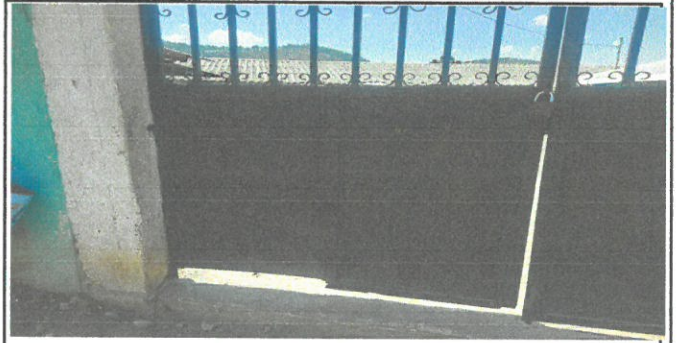
VISTA DE REMOZAMIENTO DE PORTON
