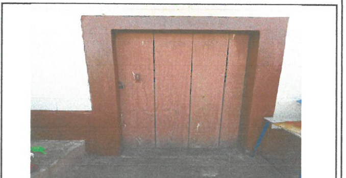
VISTA DE REMOZAMIENTO PUERTA DE COCINA
